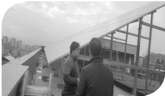
태양광 시설 설치
